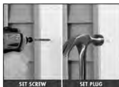
Sistema de sujeción oculta Cortex
